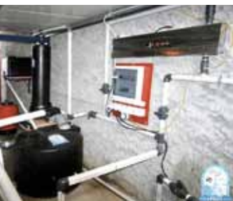
Εικόνα 39. Σύστημα εξυγίανσης οστρακοειδών από βαρέα μέταλλα σε λειτουργία (φωτο: Κ. Κουκάρας).
